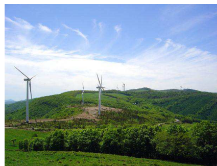
上外川高原高山風力發電廠
